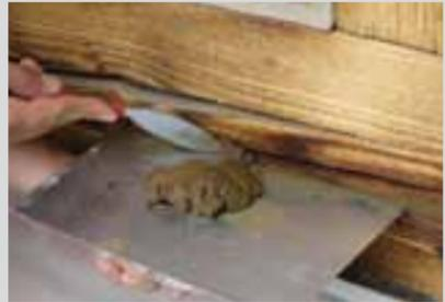
Anschließend werden die Risse (und Fugen) mit der Holzrisspaste KEIM Lignosil-HRP verfüllt, wobei je nach den Abmaßen der Risse ein geeignetes Werkzeug gewählt wird, um die bestmögliche Anwendung zu gewährleisten.
