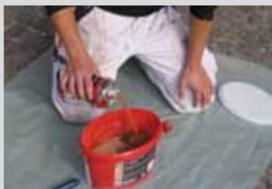
Zur Untergrundvorbereitung werden die gereinigten Risse (oder Fugen) mit der Flüssigkomponente 1 Tag vor der Verfüllung des Risses grundiert.
