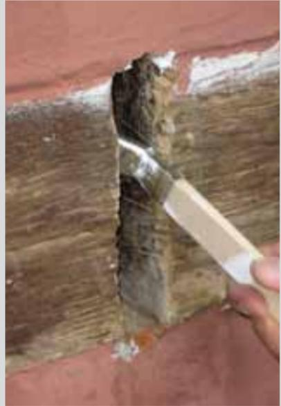
Die Fehlstellen werden nun mit der Flüssigkomponente im Abstand von einem Tag vor dem Verfüllen grundiert. Später werden die zugeschnittenen Holzstücke oder Holzkeile mit der Holzrisspaste KEIM Lignosil-HRP eingepasst und mittig in die Fehlstelle eingesetzt.
