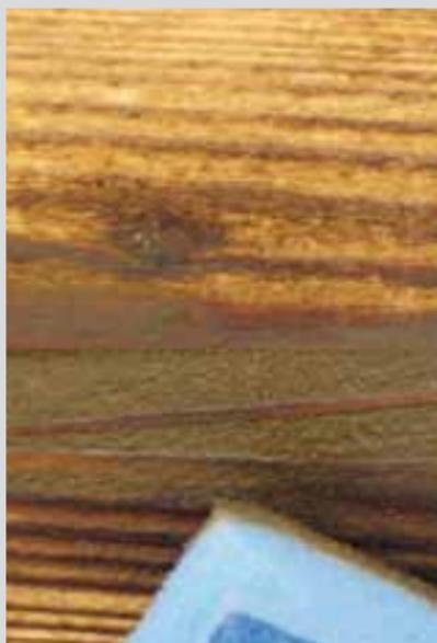
Die Risse (und Fugen) der angrenzenden Holzoberflächen werden mit der Flüssigkomponente und einem Schwamm in Faserrichtung des Holzfachwerkes gereinigt. Nach der Erhärtung der Holzrisspaste KEIM Lignosil-HRP kann diese und das Holz wie gewünscht überarbeitet werden.
